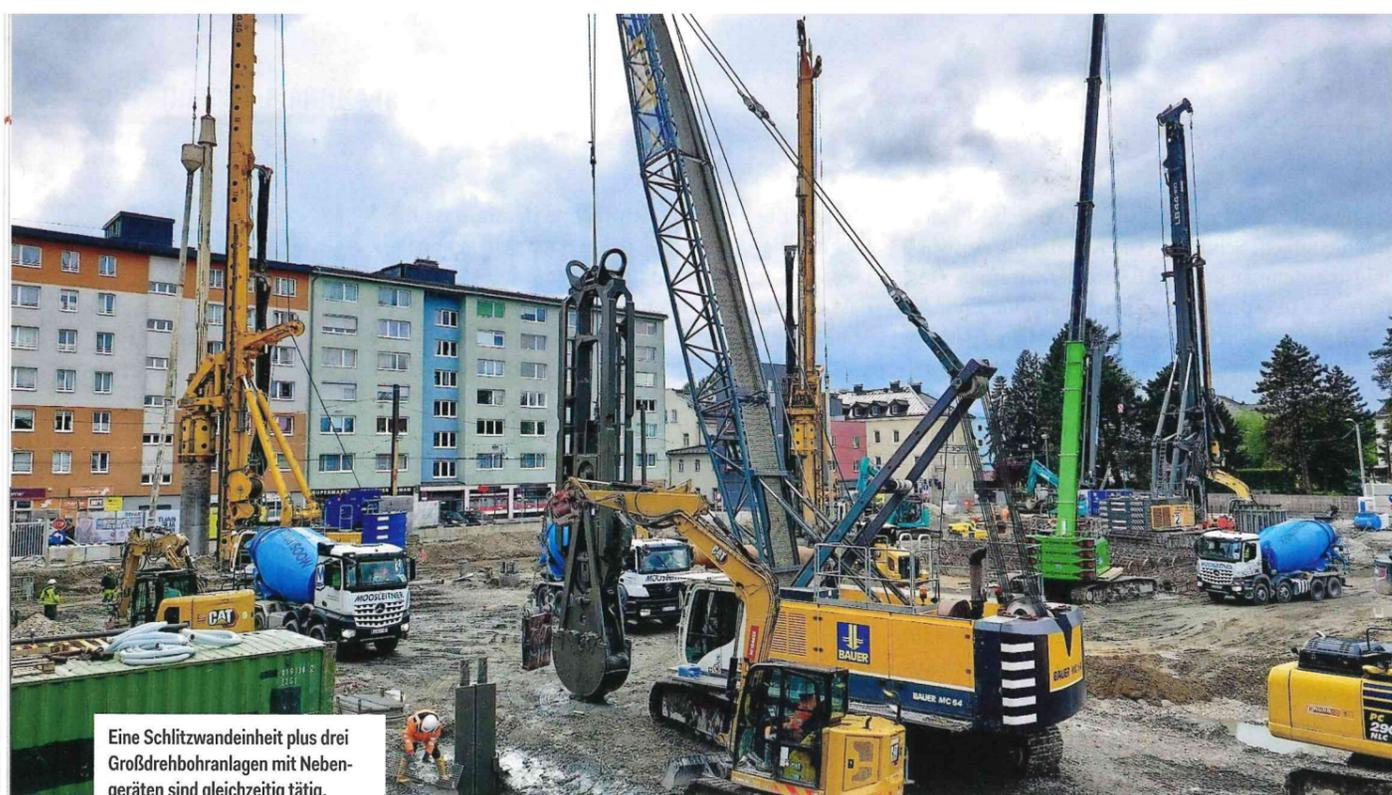
Eine Schlitzwandeneinheit plus drei Großdrehbohranlagen mit Nebengeräten sind gleichzeitig tätig.
